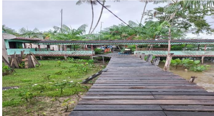
Figura 01. Ponte de entrada da Comunidade Marajó-Açu em Ponta de Pedras, PA
