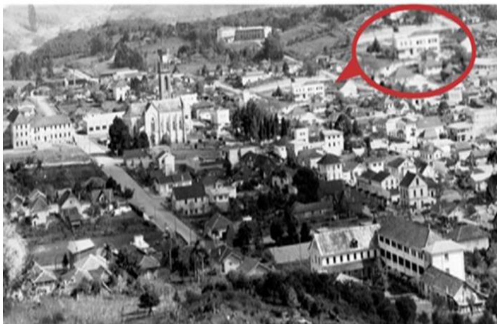
Figura 5: Foto parcial do núcleo de Flores da Cunha, 1970.
