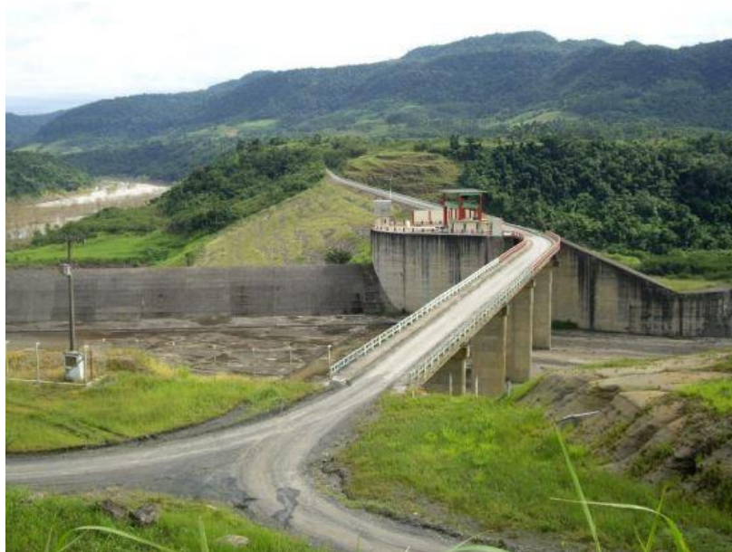
Figura 2 – Barragem Norte, construída em 1975, na TII/SC
